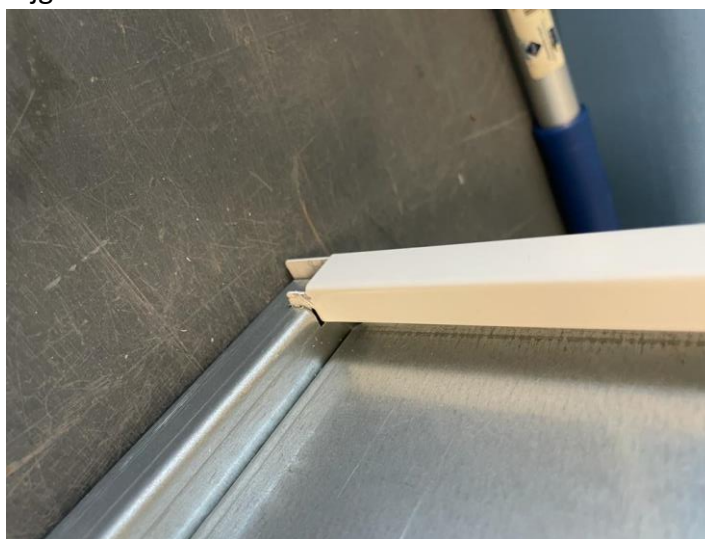
Figuur 46: Bovenkap bevestiging met haak en sleuf.
