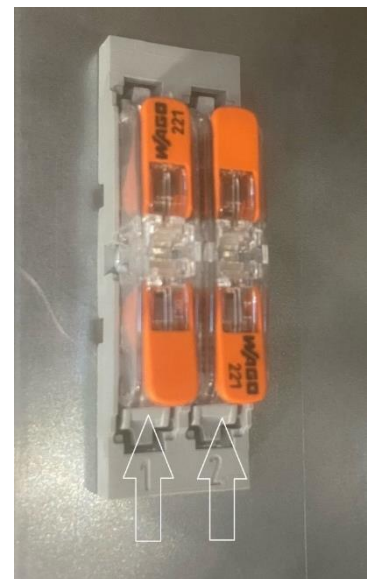
Figuur 36: Doorvoerklemmen voor de thermostaat aansluiting.
