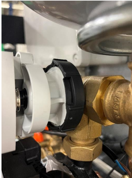
Figuur 26: 3-weg klep en servomotor met zwarte schijf.
