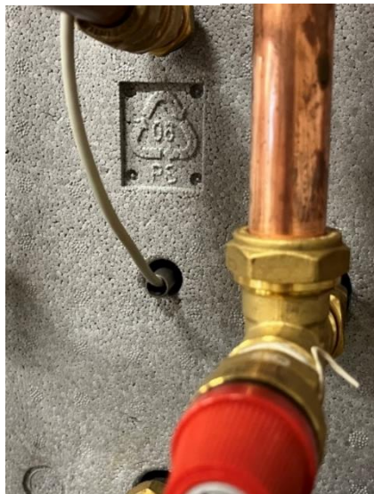
Figuur 17: Zijaanzicht van de accumulator met de temperatuur sensor gemonteerd.
