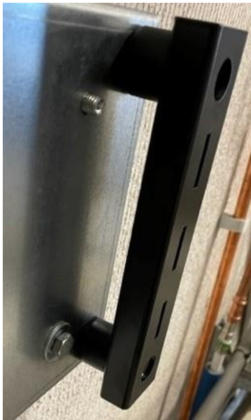
Figuur 6: Wandplaat met trillingsdempers en montagekoker.
