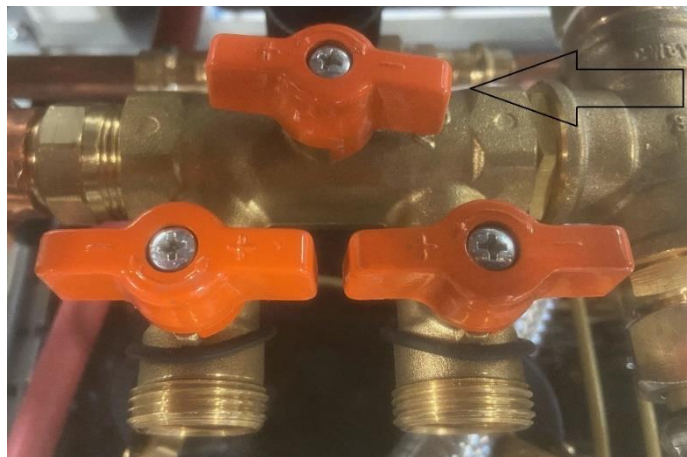
Figuur 31: Spoel- en vulkraan met alle kranen horizontaal.
